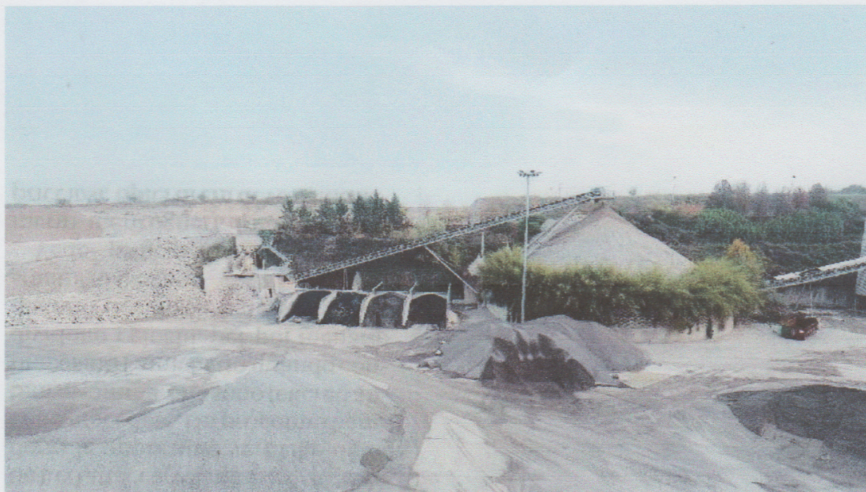
Settore da regolare. Si attendono le norme del nuovo Piano cave per le quantità di materiale da estrarre
