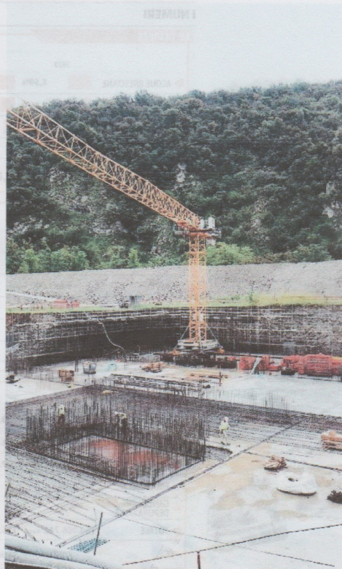
Concesio. I lavori di Asvt per il nuovo depuratore di Valtrompia
