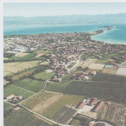
Sul lago di Garda Acque Bresciane monitorerà tutta la rete fognaria
