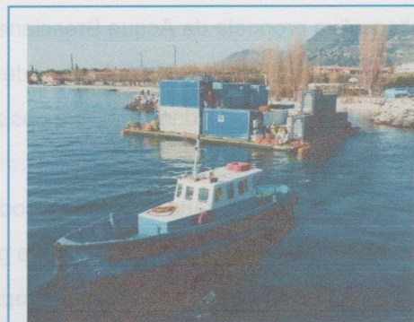
Le operazioni di restauro della condotta fognaria sublacuale di Toscolano
