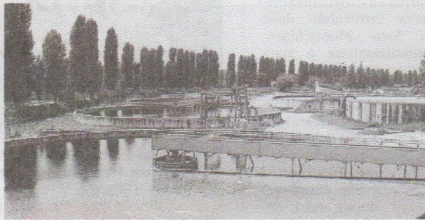
L'impianto attuale. Il depuratore di Peschiera
