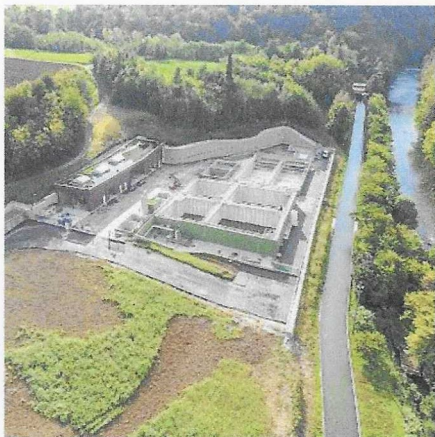
L'impianto. Il nuovo depuratore a Gavardo, a fianco del Chiese
