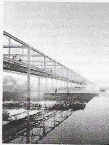
Progetto. Il depuratore del Garda
