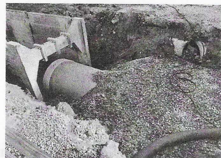
Il cantiere del collettore sulla sponda veronese del Garda
