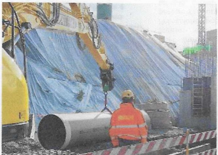
All'opera. Prime operazioni per il collettore tra Lazise e Castelnuovo
