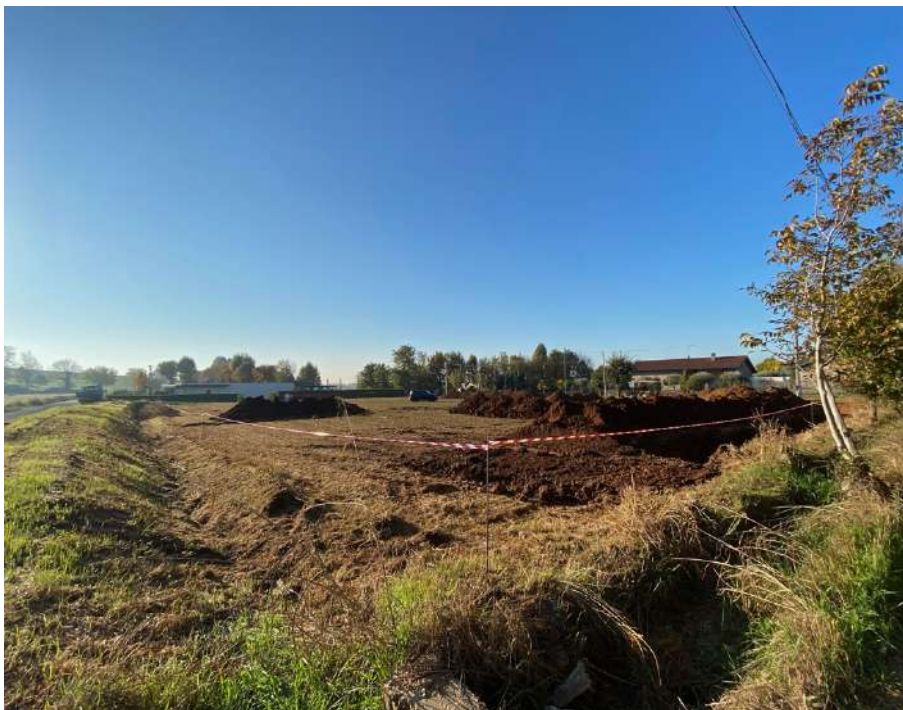
GENERALE DELL'AREA A FINE SCAVO
