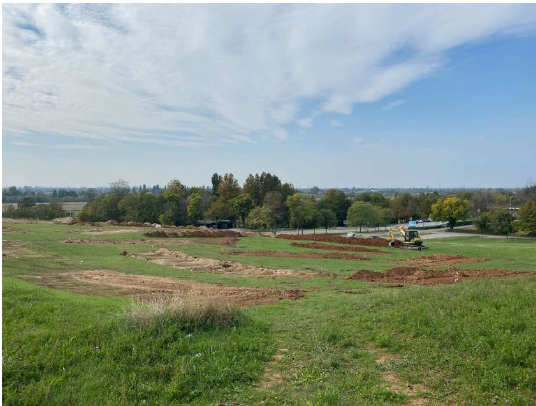
GENERALE DELL'AREA A FINE SCAVO
