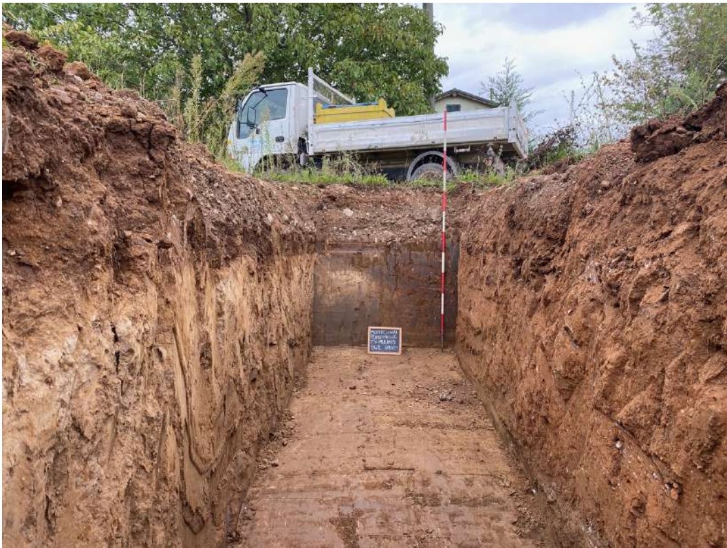
SONDAGGIO 2: SEZ. SUD
