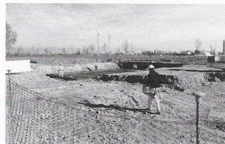
Il cantiere per la costruzione delle bretella autostradale che collega la città alla Valle Trompia
