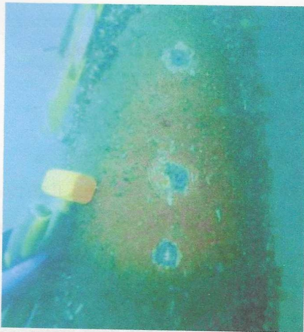
Condotte sublacuali. Lunedì è terminata la nuova ispezione
