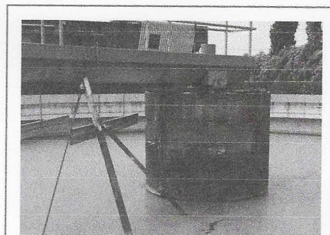
L'impianto abbandonato di Visano
